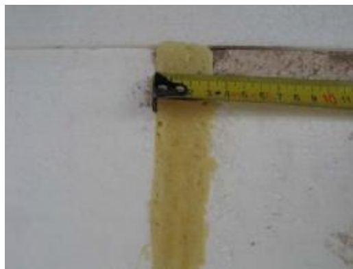
Obr. 5. Nepřípustné vyplňování nadměrných spár PUR lepidlem
