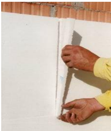
Obr. 4. Vyplňování spár přířezem
