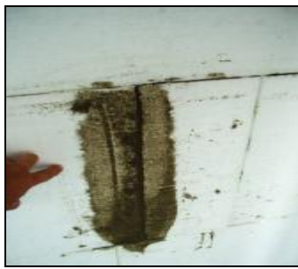
Obr. 2. Nepřípustné je vyplňování mezer cementovým lepidlem.
